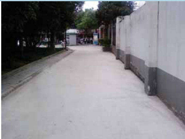
图2: 维修后的道路
