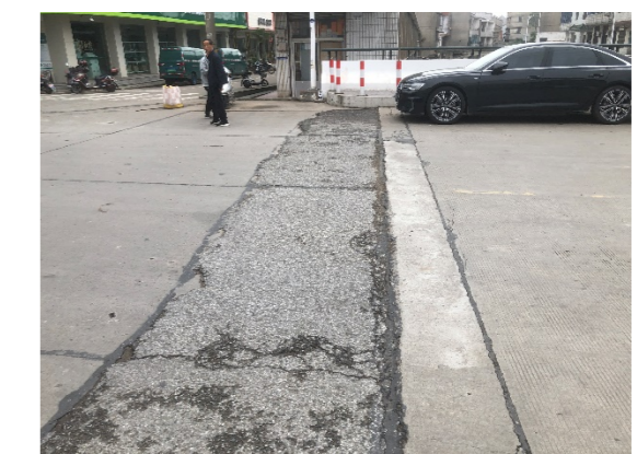
图 4-18 南侧桥头板块
