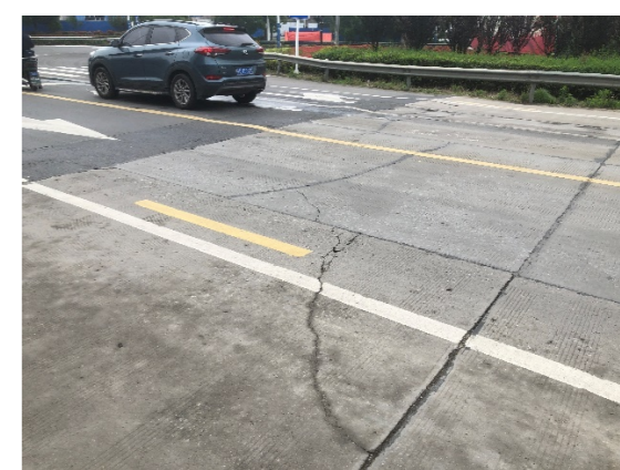
图 4-10 板角破损
