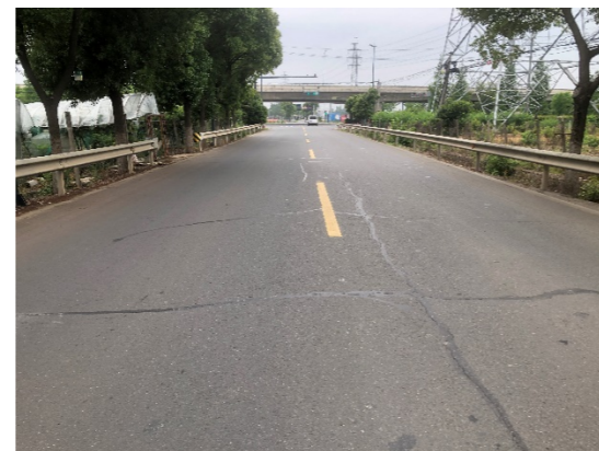
图 4-24 横向裂缝
