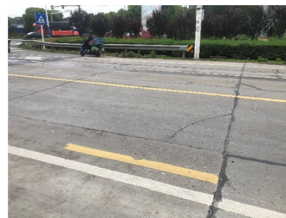
图 4-9 板角破损
