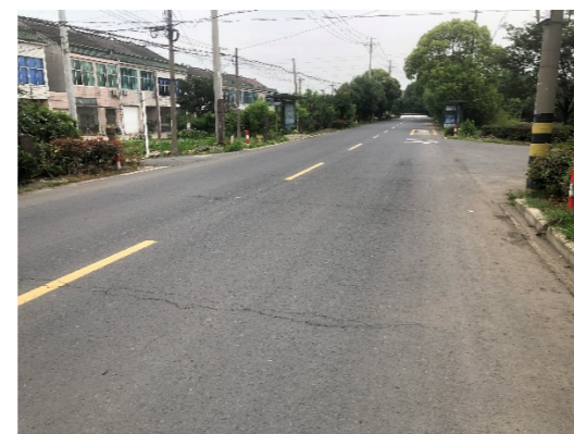
图 4-26 横向裂缝
