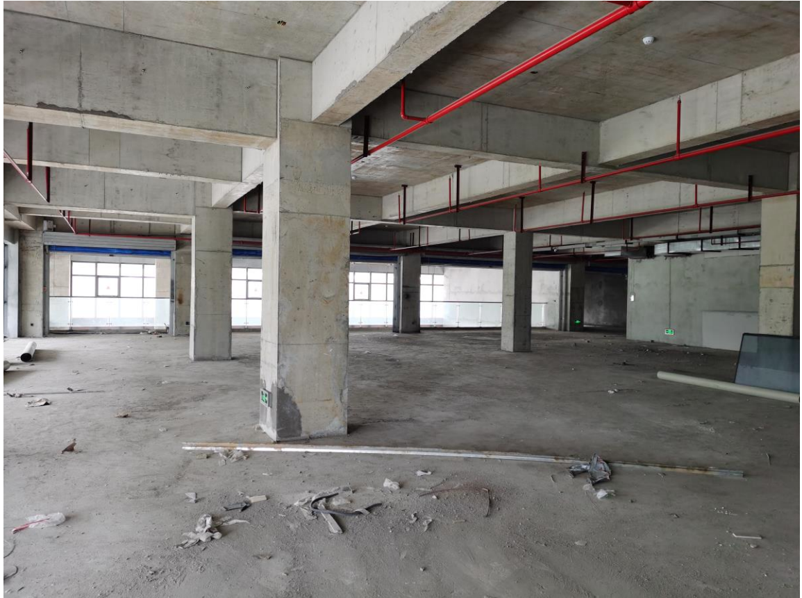
拟建设区域现状：测试实验楼 D 座二层
